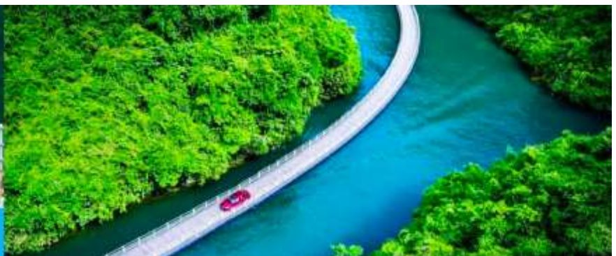
บ่อร์รถผ่านชมถนนลอยน้ำด่านลิ่งโก
