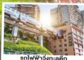
รถไฟฟ้าชิงเกะลุติง
