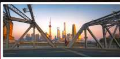
สะพานไวปู้
