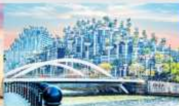
อาคารฟันทันไม
