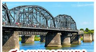
สะพานหวาดถานตง
